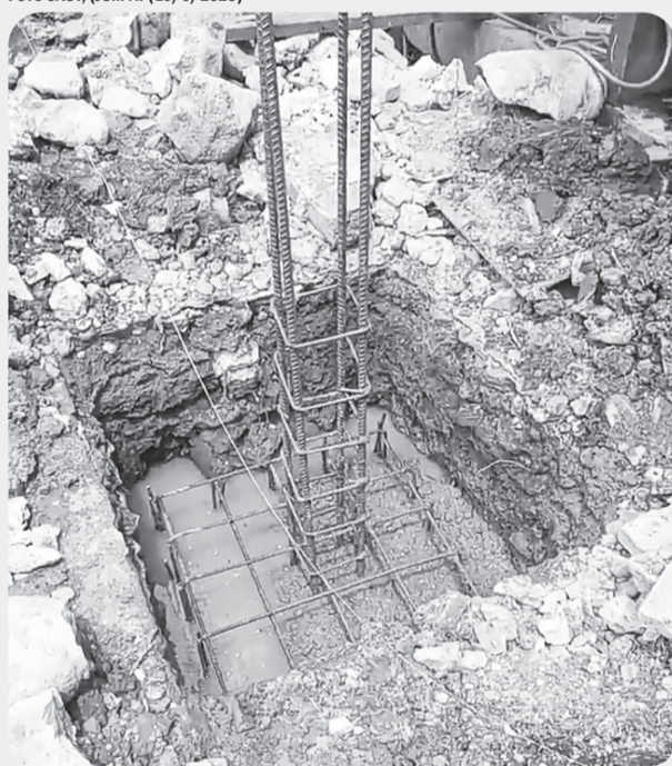
DIGENANGI AIR: Pengecoran pondasi cakar ayam Pembangunan SMPN 19 Kota Bekasi saat masih digenangi air.
