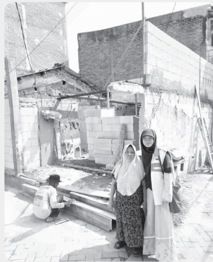
Anggota Komisi II DPRD Kota Tangerang, Yeni Kusumaningrum melakukan peninjauan langsung ke lokasi pembangunan bedah rumah.
