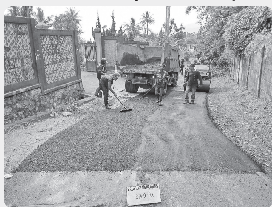
Dinas PUPR Kabupaten Bogor sedang mengerjakan perbaikan infrastruktur jalan di beberapa wilayah Kabupaten Bogor.
